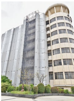
16号館はほぼシートで覆われています(2022年9月撮影)
