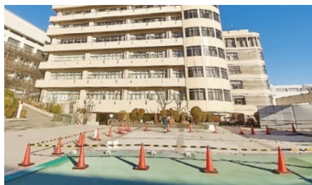
はとの広場のタイル補修が進んでいます(2024年1月撮影)
